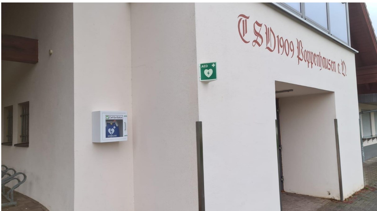
Das Foto zeigt den Montageort an der Fassade des Sportlerheims.
